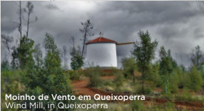
Moinho de Vento em Queixoperra Wind Mill, in Queixoperra
