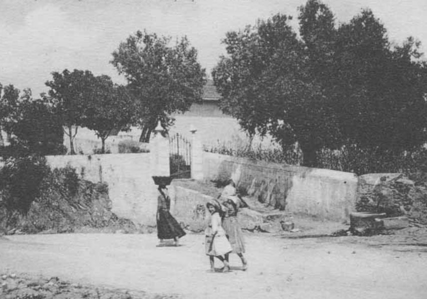
11. - Depósito de água da Câmara Municipal que abastece a Vila
